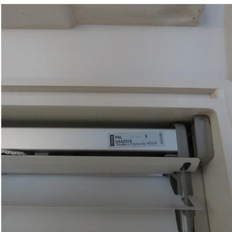
**STORES:** La plaque d'identification se trouve soit au dos du coffre du store ou de la barre de manœuvre, visible à travers la vitre quand le battant de la fenêtre est retourné à 180°).
