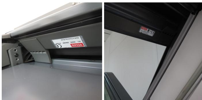
**VOLETS ROULANTS :** La plaquette d'identification se trouve en sous-face de la 1ère lame du tablier, dans l'angle de droite. Si le volet est complètement fermé, il est nécessaire de s'aider d'un petit miroir ou de prendre une photo avec son téléphone.
